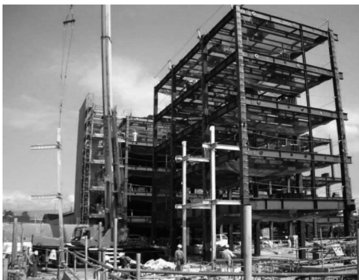
图 3-4 钢框架结构施工现场
